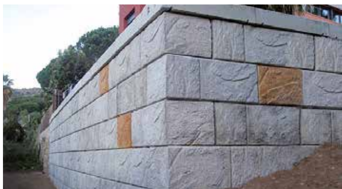
As axudas poden destinarse á mellora dos muros de peche das vivendas
